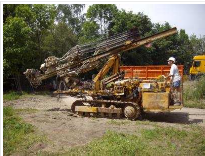
Bohrer zum Bohren der Löcher für die Gewindeanker
