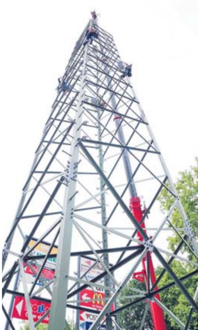
Hoch oben erledigen die Mitarbeiter von Alpine-Energie ihren Job. Dafür wurde die Westtangente am Sonntagmorgen gesperrt. Foto: Stefan Fries
