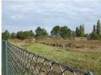
Beräumungsarbeiten auf der Brache.
